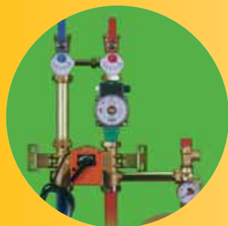
Circuito di riscaldamento per intemperie
