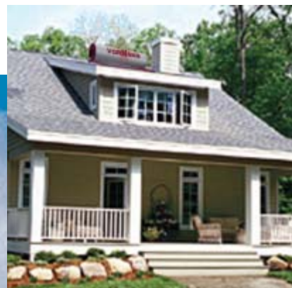
Installazioni civili Vormann Solar
